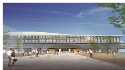
JR 長崎駅 外観(提供：JR九州 鉄道・運輸機構)
